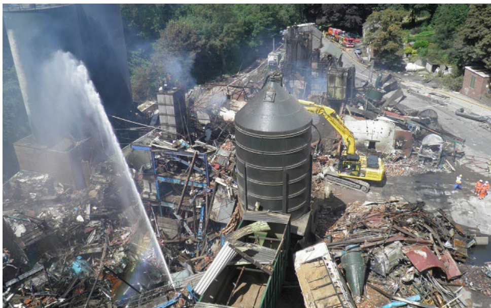
Figura 16. Destrucción provocada por la explosión en la fábrica de suelos laminados de Bosley (UK). Fuente: (Amyotte, 2014).
