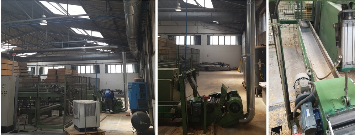
Figura 24. Fotografías de las instalaciones en el interior del aserradero. Fuente: cesión de fotografías realizadas por la empresa Atmósferas Explosivas ( www.atmosferasexplosivas.es ).
