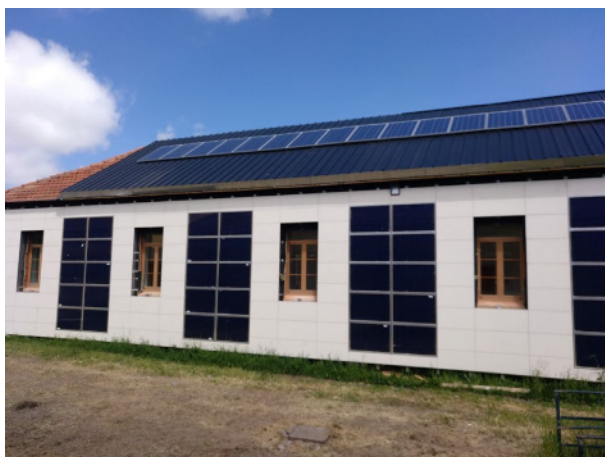
Figura 5. Aspecto durante las actuaciones de BRESAER.
